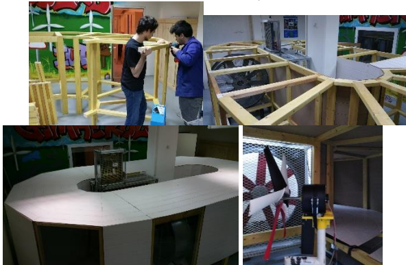
Figure 48 : construction de la soufflerie du GIMaéroLab et Dionysienne en zone d'essai.
